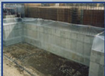
土木地下コンクリート構造物の内外壁及び基礎
