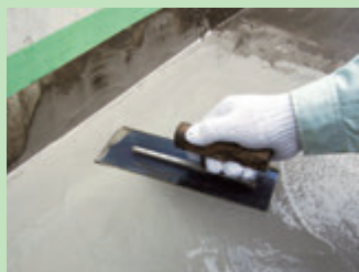
コテ塗り施工
