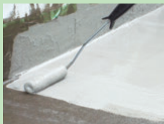
ローラー塗り施工
