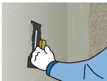
コテ塗り施工
